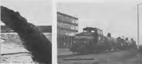
MER CU construction cuminsa, sitio di e refineria masier a worde eleva cuarenta y cinco pia. Intra esaki, 6,000,000 yarda cubico di ton y santo a worde treci hidraulicamente pa e sitio di construction.
